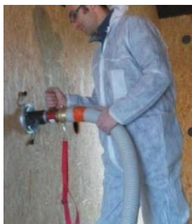
Insufflation isolante en vrac
